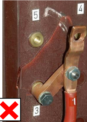
Fig. 11: Ikke tilladt! Overfladerne kan splintre på grund af voldsom kraft på trekantforbindelsen
