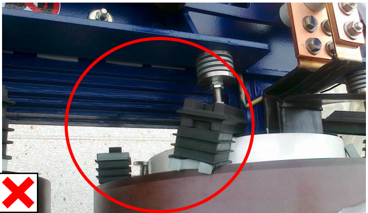
Fig. 14: Ikke tilladt! Viklingerne har forskubbet sig. Det kan ses ved, at støtterne er revet ud.
